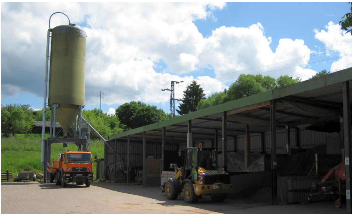
Abb. 8: Ansicht der Lagerhalle des Baubetriebshofs Eppelborn
