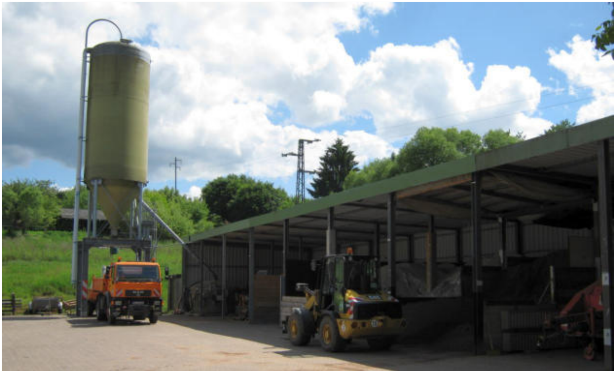
Abb. 8: Ansicht der Lagerhalle des Baubetriebshofs Eppelborn
