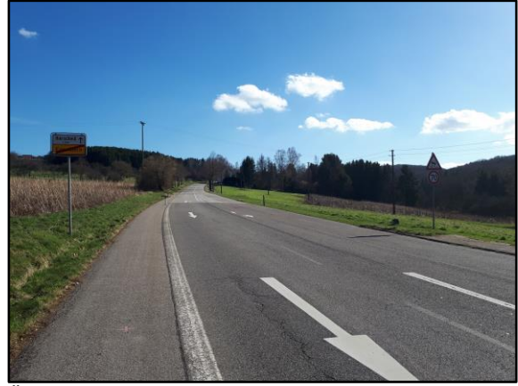
Übergangsbereich zur freien Strecke
