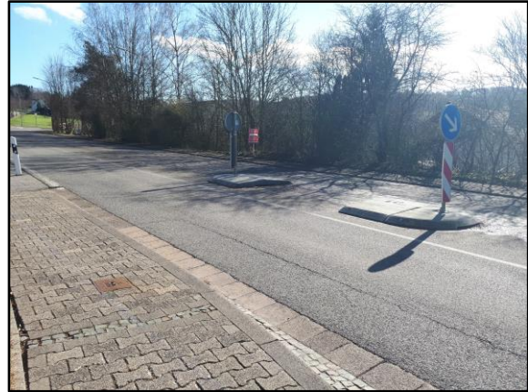
L 302 Schloßstraße, vorh. Querungsstelle
